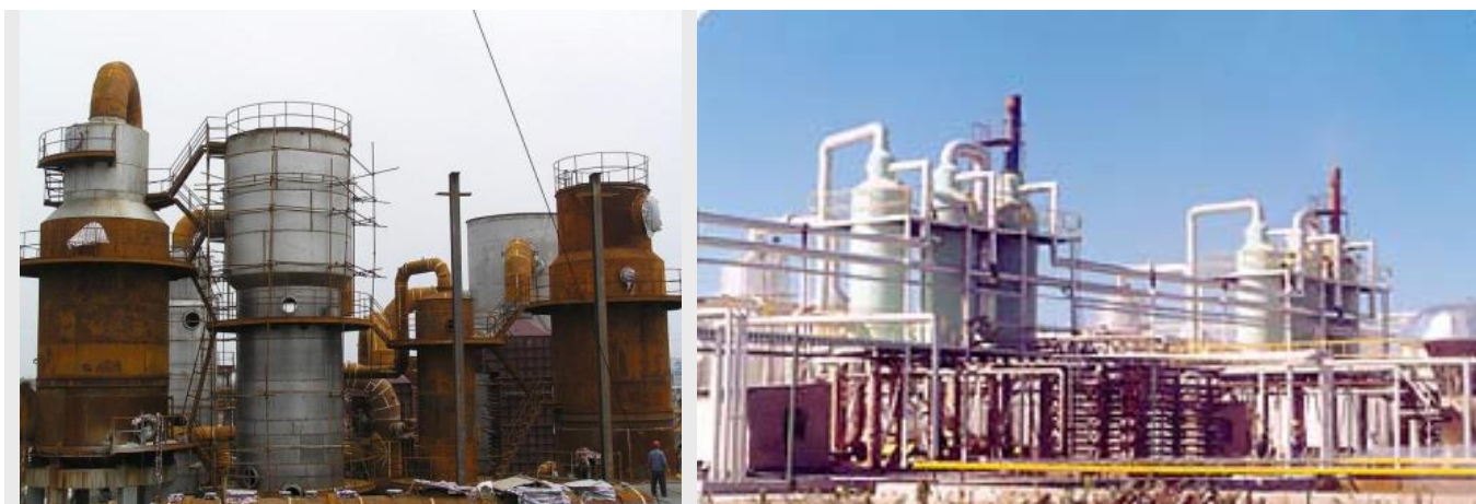
Современный завод серной кислоты
