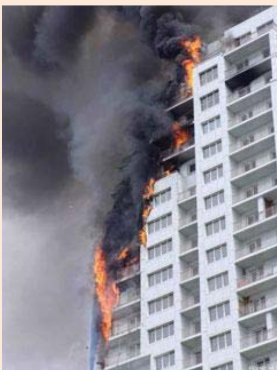
Пожар в незаселенном доме, утепленном пенопластом
