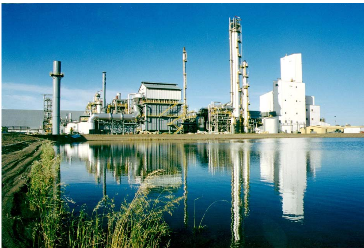
Установка по производству аммиака мощностью 1500 т/сутки и комплекс удобрений компании Saskferco Inc. в Канаде.
