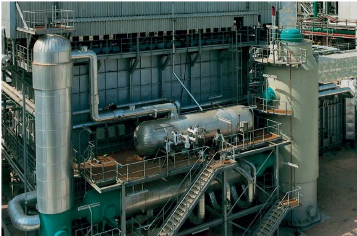
Реактор вторичного риформинга Uhde и система охлаждения технологического газа
