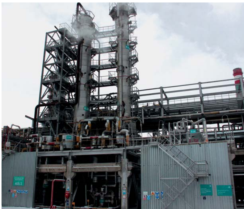
Рис. 47. Слева колонна получения товарной БДФ, справа — колонна — вторичный депропанизатор БДФ
