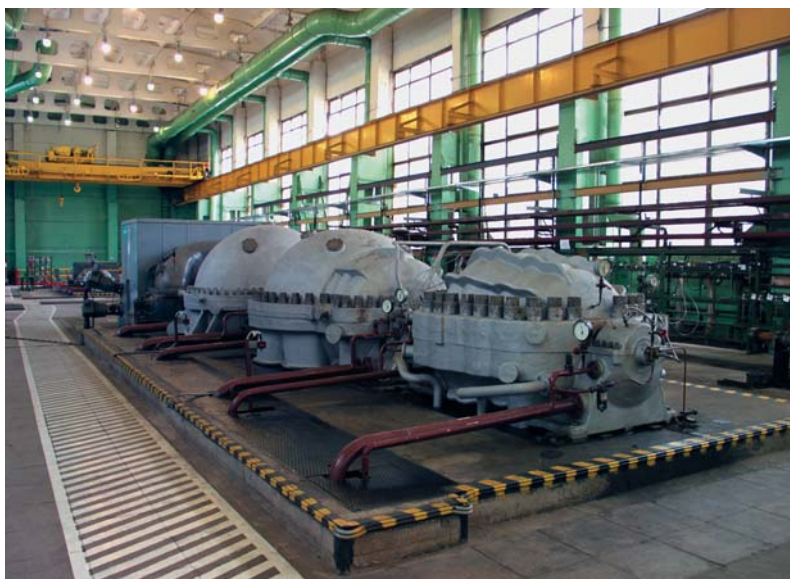
Рис. 41. Один из турбоагрегатов цеха компримирования
