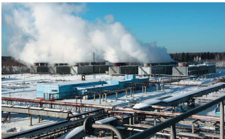
Рис. 65. Установка получения деминерализованной воды. Водяной пар поднимается над градирнями, где происходит охлаждение горячего конденсата за счет температуры окружающей среды
