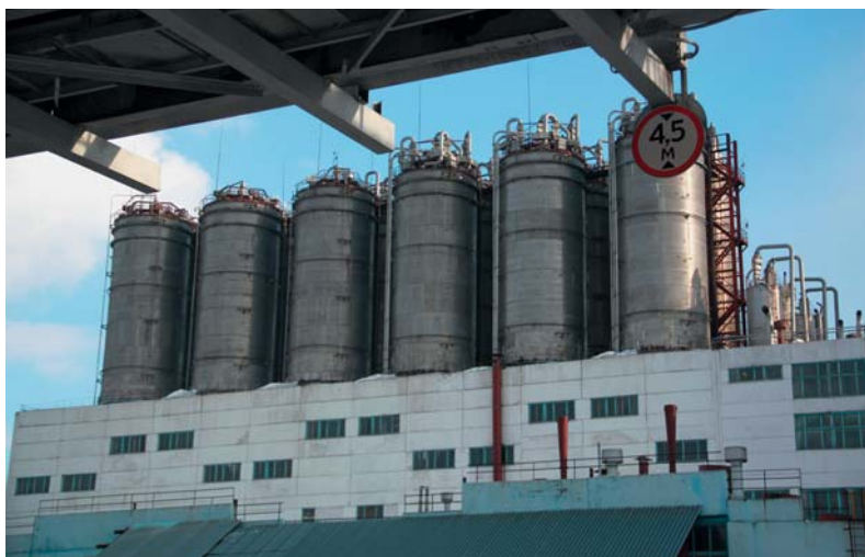
Рис. 55. Товарные бункеры полиэтилена высокого давления
