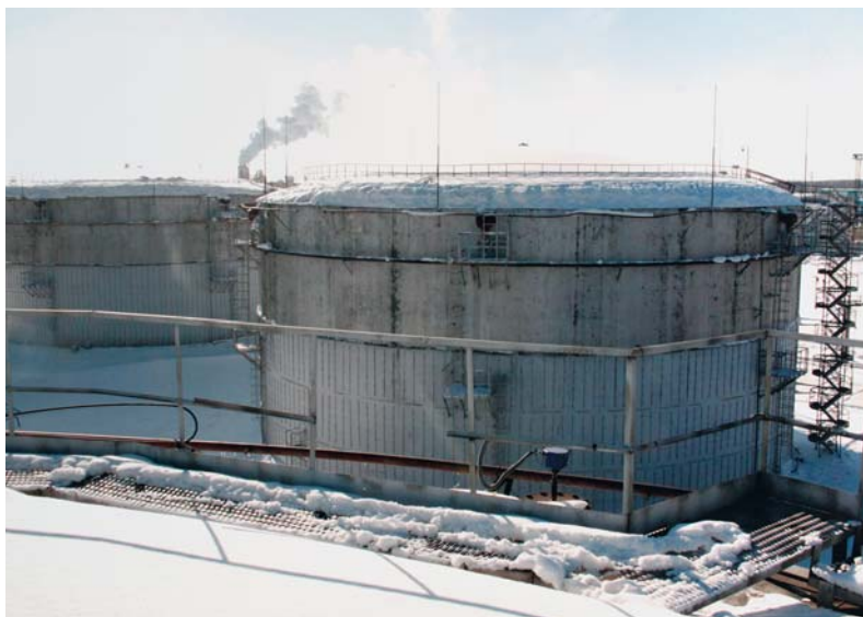
Рис. 32–33. Емкости для хранения газообразного сырья (вверху) и бензина (внизу)
