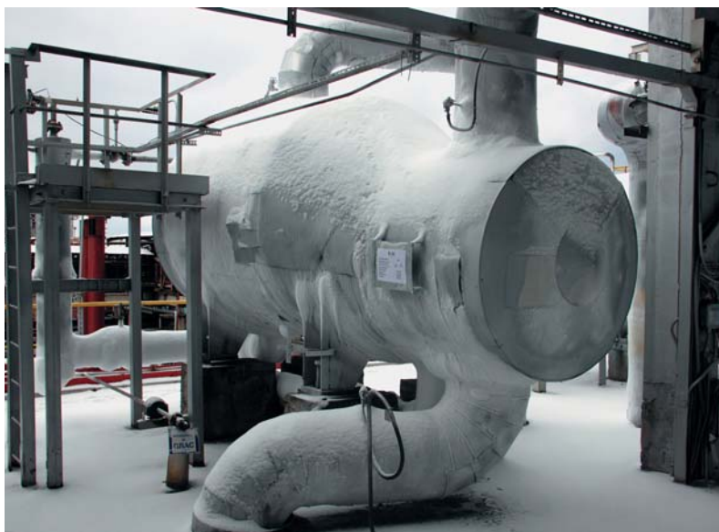
Рис. 43. Один из теплообменных аппаратов блока выделения метана и водорода. Здесь охлаждающим агентом выступает жидкий этилен, а пирогаз охлаждается до температуры -55^{\circ}\text{C}
