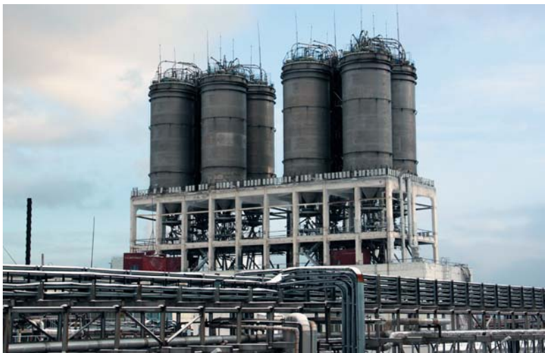
Рис. 63. Товарные бункеры производства полипропилена
