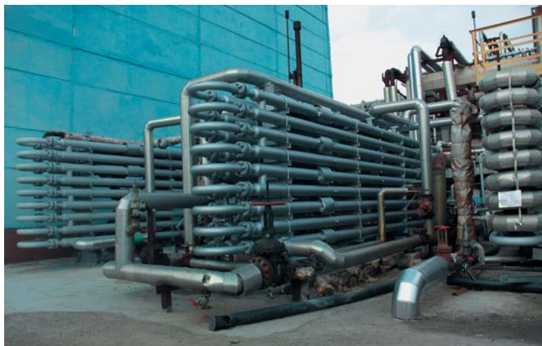
Рис. 52. Теплообменные аппараты, через которые проходит ВГВД
