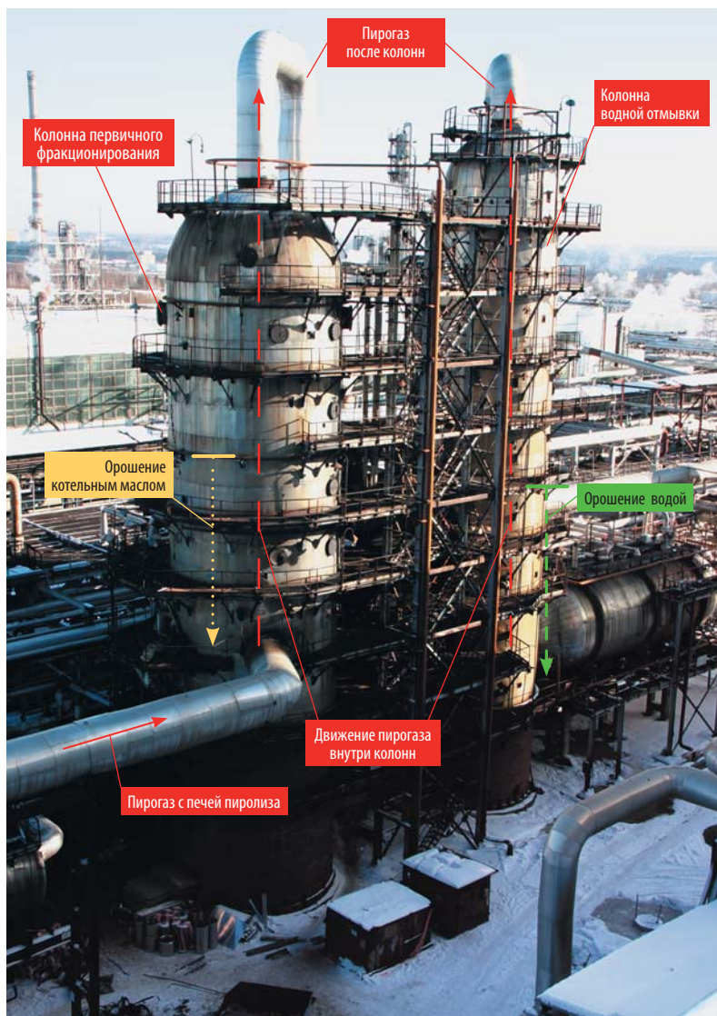
Рис. 38. Колонна предварительного фракционирования — слева. Виден трубопровод, подводящий пирогаз от печей в нижнюю часть аппарата. Колонна водной отмывки правее. Справа отстойник-разделитель смеси воды и пироконденсата
