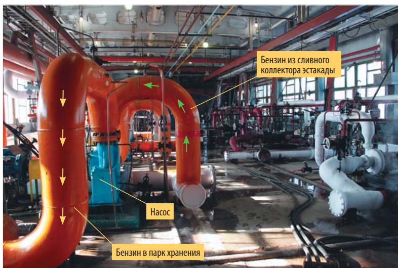
Рис. 31. Насосы по перекачке сырья со сливной эстакады в парк хранения
