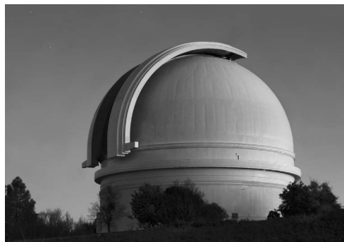
Башня 200-дюймового рефлектора Паломарской обсерватории (Калифорния) с полусферическим куполом и раздвигающимися створками щели
