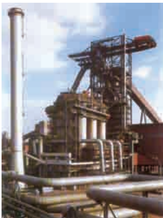
Большая доменная печь для производства более 6000 тонн чугуна в день
