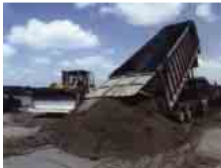
Рис. 9. Использование ЛЗ в насыпных работах
