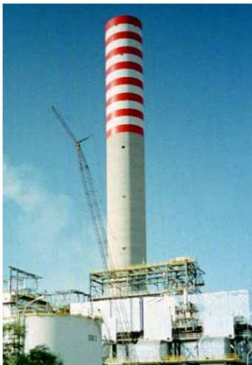
Установка СНОКС на 1,000,000 \text{nm}^3/\text{ч} на ТЭС Agip Petroli SpA в г. Гела, Италия
