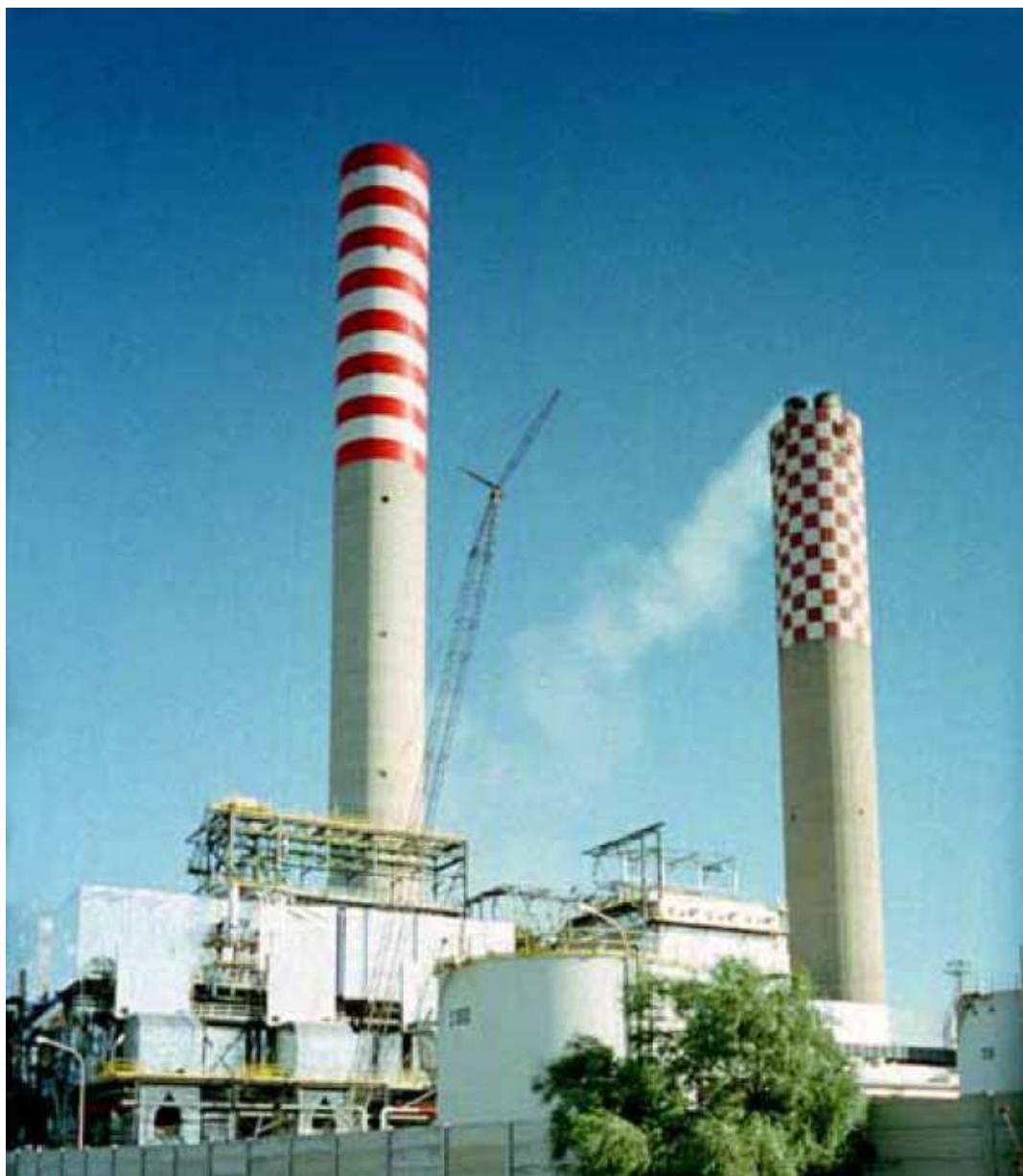
Рис.2.14. Установка СНОКС для очистки дымовых газов от 3 котлов, сжигающих высокосернистый нефтяной кокс на НПЗ Agip Petroli в Гела, Сицилия. Через трубу слева отводится 1 млн \text{м}^3/\text{час} дымовых газов, очищаемых на установке СНОКС. Через правую трубу отводятся дымовые газы от 4-ого котла, не присоединенного к установке СНОКС.
