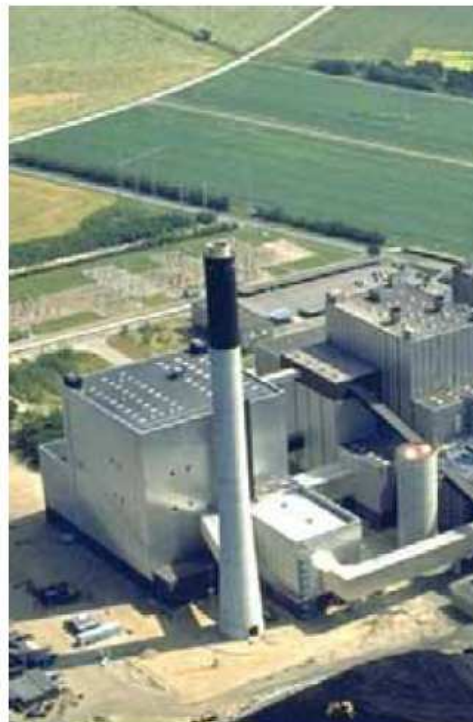
Угольная ТЭС мощностью 300 МВт, оборудованная установкой СНОКС в NEFO (Nordjyllandsværket), Дания
