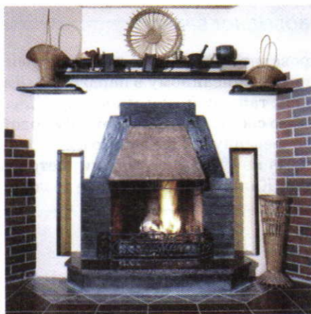
Рис. 37. Топка камина. При устройстве печей и каминов всегда стремятся создать тягу
