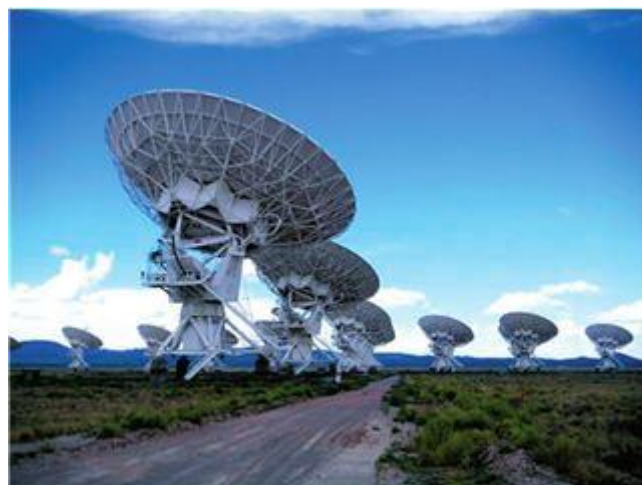
Радиоастрономическая обсерватория в Сокорро (США), состоящая из 27 радиоантенн диаметром 25 м каждая Фото из Википедии
