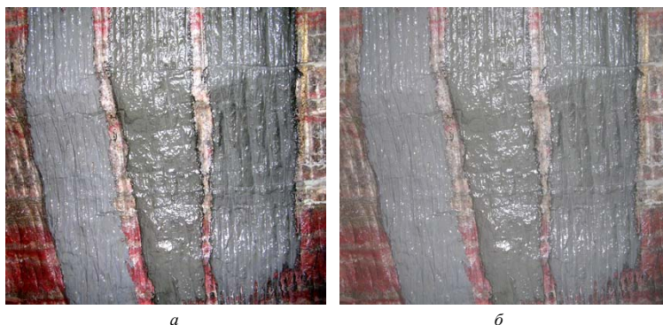
Рис. 114. Вид покрытий, нанесенных на поверхность солевого пласта в вентиляционном штреке 2-го рудоуправления ОАО «Беларуськалий» непосредственно после формирования ( а ) и через год эксплуатации ( б )
