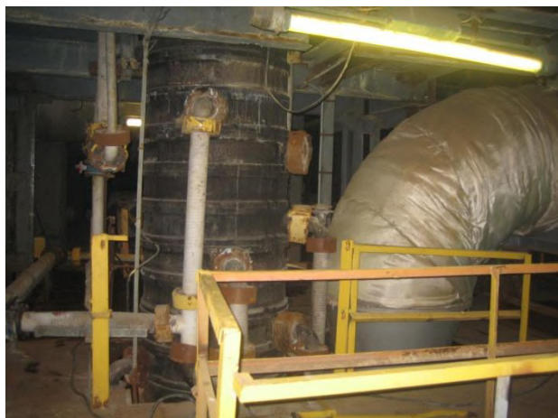
Рис.4.16. Фотография вихревой ферросилидовой колонны в средней части аппарата в области входа газов в колонну
