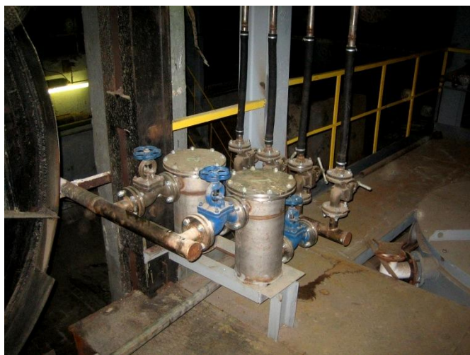
Рис.4.34. Фильтры очистки воды
