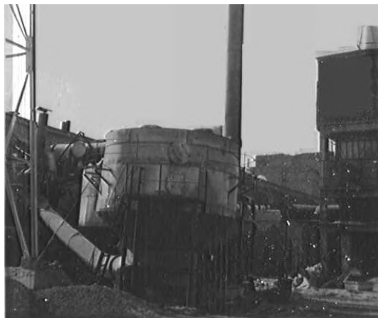
Рис. 2.44. Реактор каталитического восстановления оксидов азота (г. Стерлитамак)
