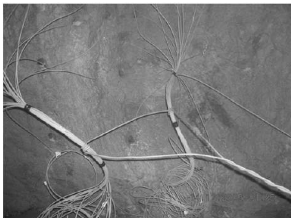
Рис. 9.14. Правильный монтаж взрывной цепи
