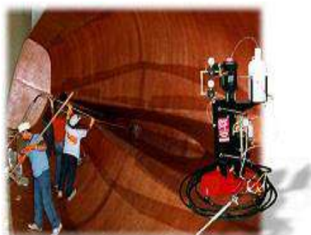
Рисунок 2.2 – Укладка с применением установки приготовления и дозированной подачи связующего
