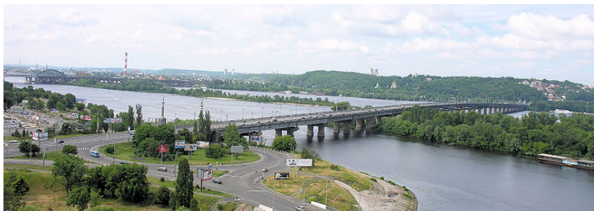
Рис. 8.1. Мост имени Е.О. Патона (мост Патона) – один из мостов через Днепр в Киеве, первый в мире цельносварной мост (длина – 1543 м, ширина проезжей части – 21 м, построен в 1953 г.)
