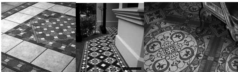
Рис. 3.5. Полы, настиленные керамической плиткой
