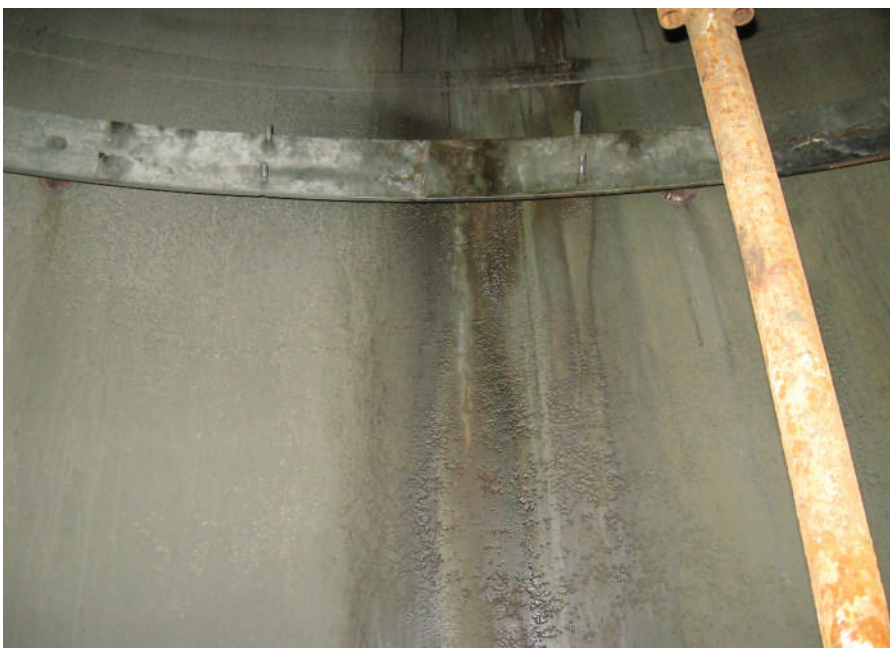
Рис. 3.9. Точечная коррозия на обечайке абсорбера очистки газов от кислых компонентов (общий вид внутри абсорбера)
