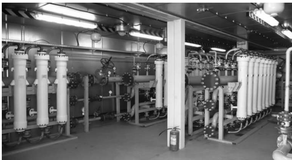
Рис. 7.3. Внутри установки подготовки попутного нефтяного газа по мембранной технологии
