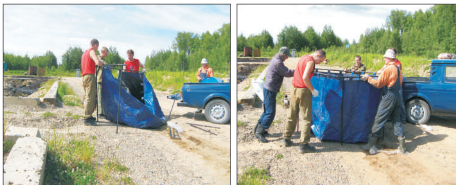
Рис. 4.23. Установка специальной емкости для приготовления рабочего раствора моющей композиции.
