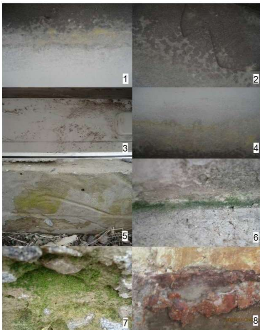
Рисунок 1 - Биоповреждение строительных материалов: 1, 2, 3, 4 – мицелиальными грибами; 5, 6 – водорослями; 7 – мхами; 8 – железо- и тионовыми бактериями [17]
