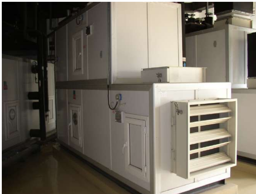
Рис. 6. Установка подготовки воздуха для вентиляции и кондиционирования чистых помещений
