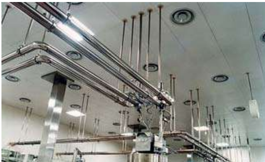
Рис. 8. Кольцевые системы циркуляции воды очищенной и воды инъекционной
