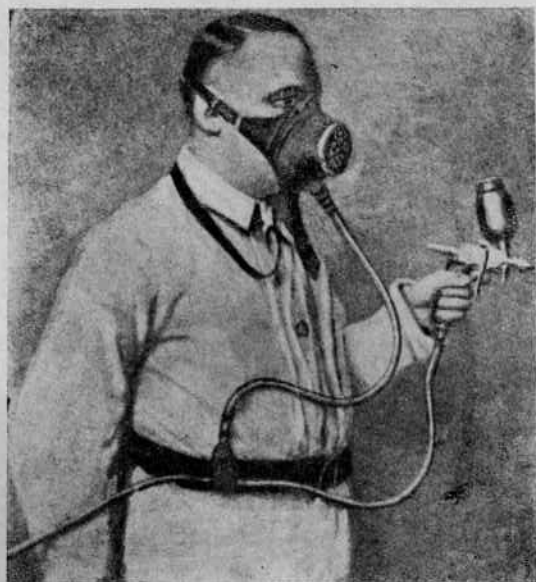
Рис. 66. Шланговый прибор с давлением, при- соединенный к рукаву аппарата для распыли- вания красок (фирма Ауэр).
