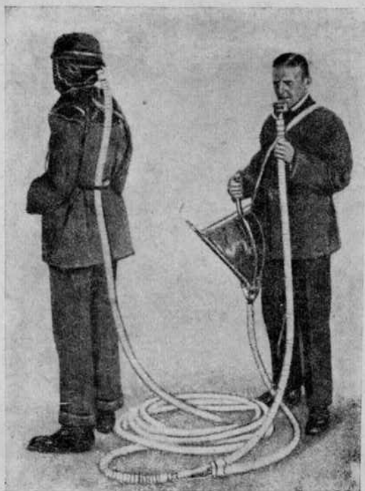
Рис. 65. Шланговый прибор с давлением (фирма Ауэр).
