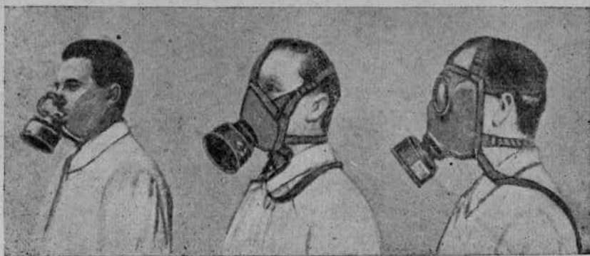
Рис. 75а. Фильтр для дыхания с простым мундштуком.
